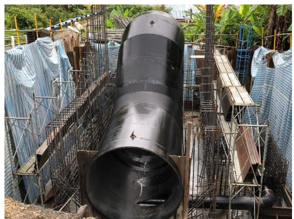
鏡面水庫水管橋：A1 橋台 鋼筋綁紮
