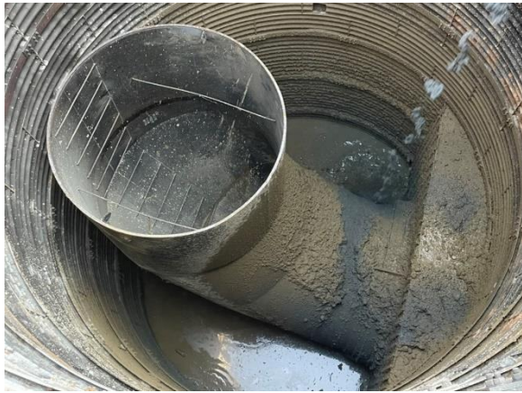
W48 工作井：工作井回填作業
