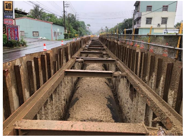
三埔段：21k+997~22k+058 CLSM (工地型拌合) 回填
