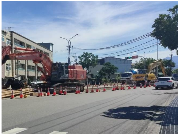
中正段：17k+803~17K+850 管溝開挖
