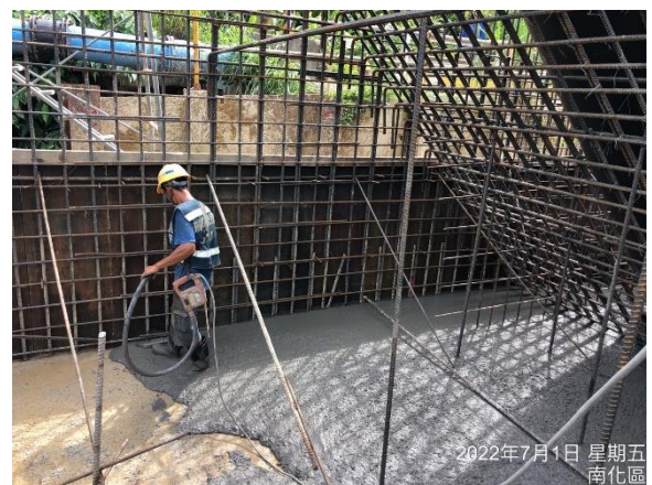
鏡面水庫水管橋：A2 橋台 第四層澆置
