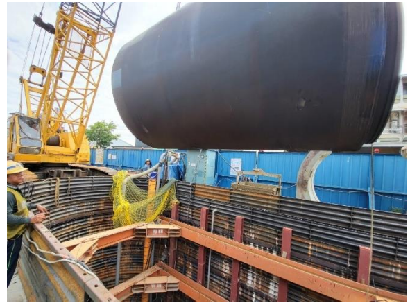
W44 工作井：推進工程施工
