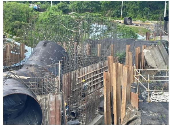
三埔水管橋：A1 橋台 第一層模板組立
