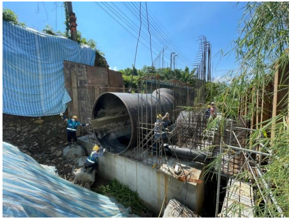
沙田水管橋：A1 橋台 鋼管吊裝
