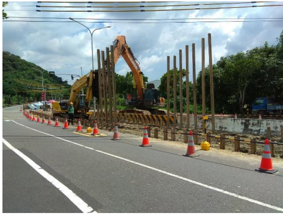
中正段：16k+770~16k+830 鋼軌樁打設
