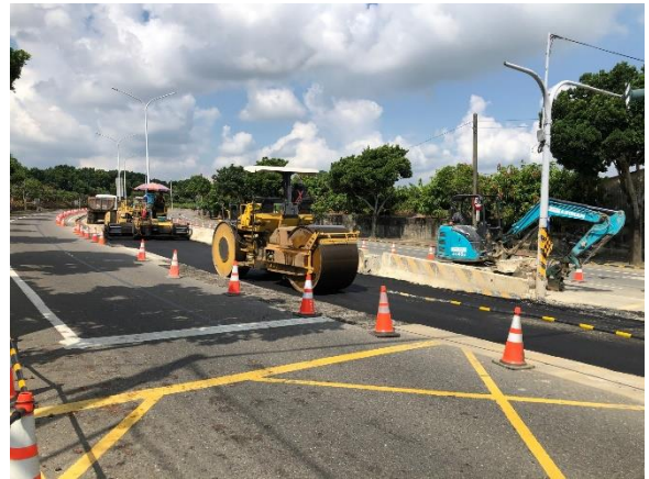
中正段：16k+915~17k+035 瀝青鋪築
