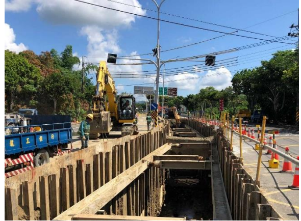
中正段：16k+747~16k+808 管溝開挖及水平支撐施作
