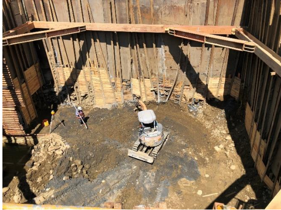
W38 工作井：開挖整地
