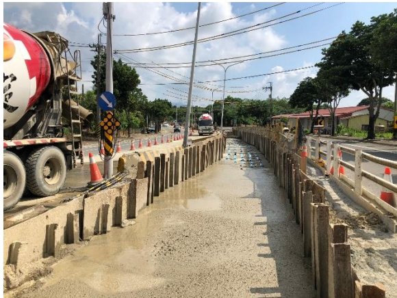
中正段：16k+830~16k+891 CLSM (工地型拌合) 回填
