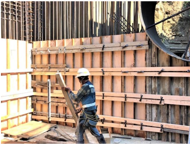
W38 工作井：IV-08 球閥窰井 第一層牆身模板組立
