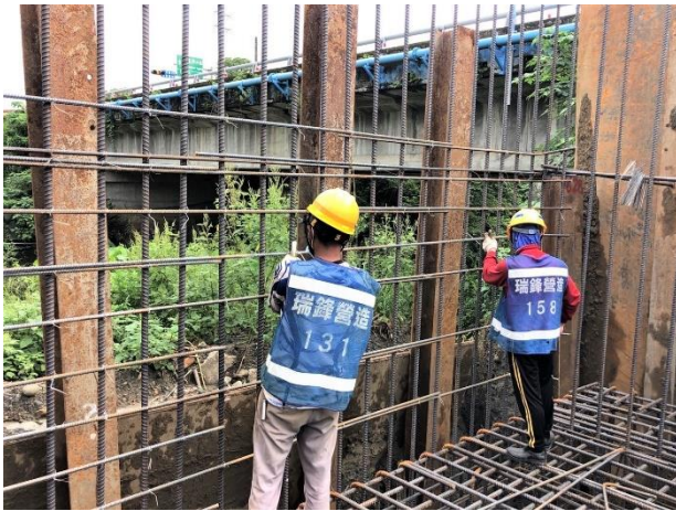
沙田水管橋：A2 橋台基礎 鋼筋綁紮
