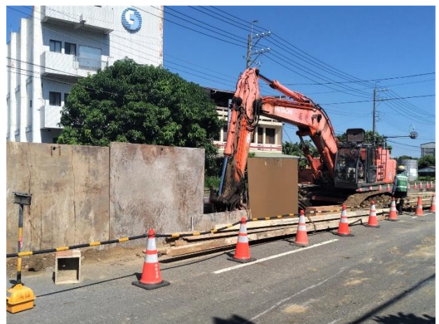
北寮段：24k+177~24k+215 鋼管吊裝
