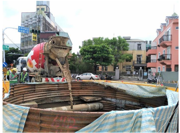
W45 工作井：工作井回填作業
