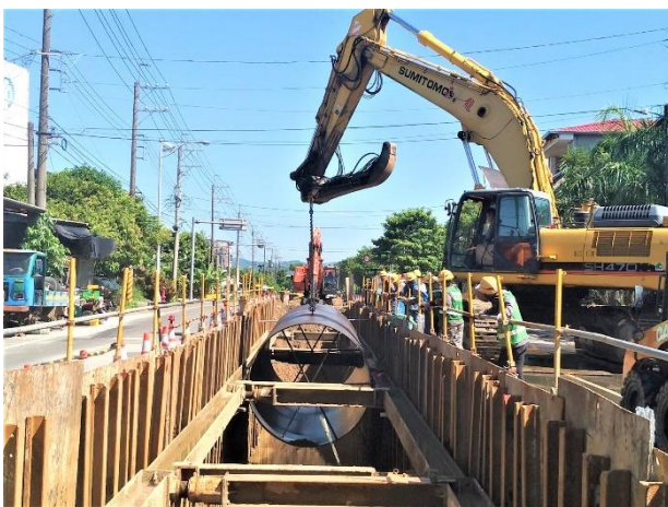
北寮段： 24k+093~24k+177 擋土鋼鈹打設
