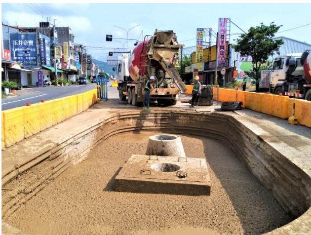
W44 工作井：工作井回填作業
