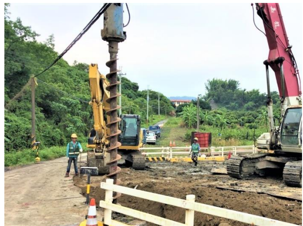
鏡面水庫水管橋： A2 橋台可撓管窰井擋土支撐打設
