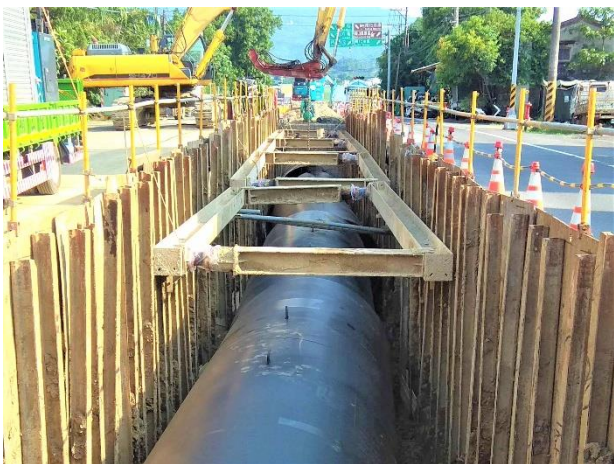
北寮段：24k+139~24k+177 鋼管吊裝
