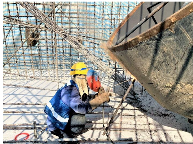
沙田水管橋：A2 橋台鋼管銲接
