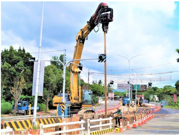
中正段： 16k+723~16k+745 鋼軌樁打設
