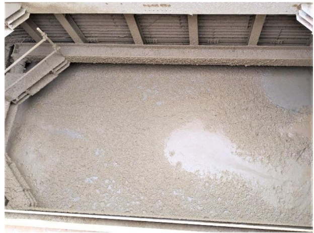
W43 工作井：工作井回填作業
