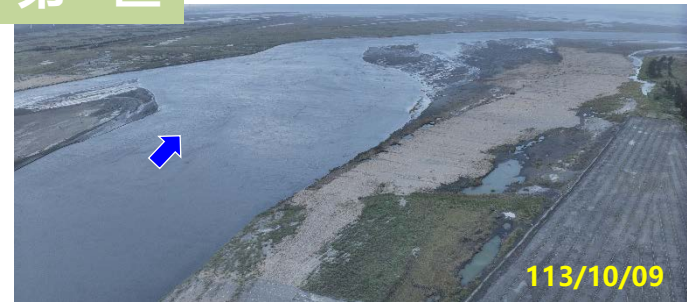
第一區 7號越堤路段 下游
