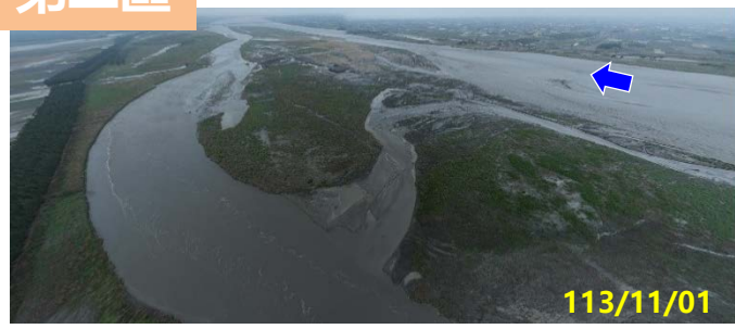
40號越堤路 上下游
