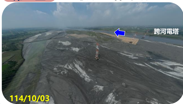
第三區 跨河電塔 下游
