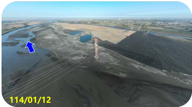
第三區 跨河電塔 下游
