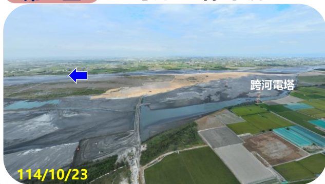
第三區 跨河電塔 下游
