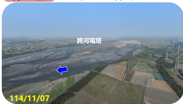
第三區 跨河電塔 下游
