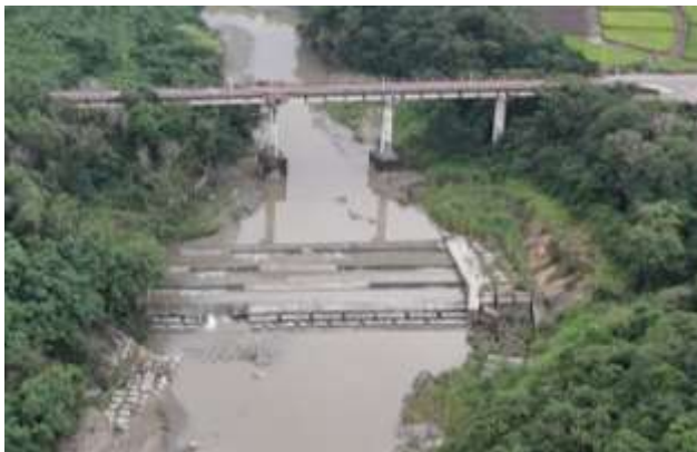
七號固床工(仁義潭大橋)
