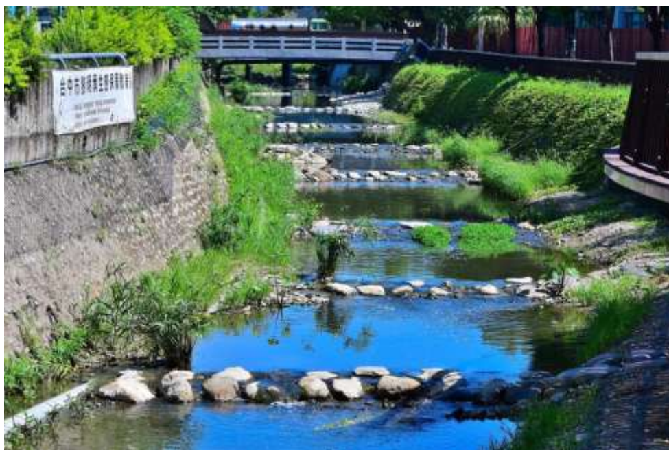
圖 3.52 渠道營造跌水曝氣與多樣性流況
