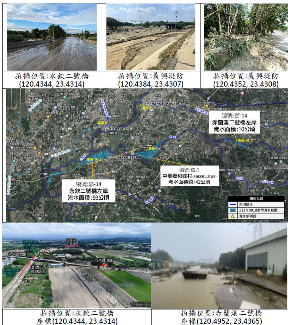
圖 2.42 赤蘭溪堤防溢提段淹水照片及淹水範圍
