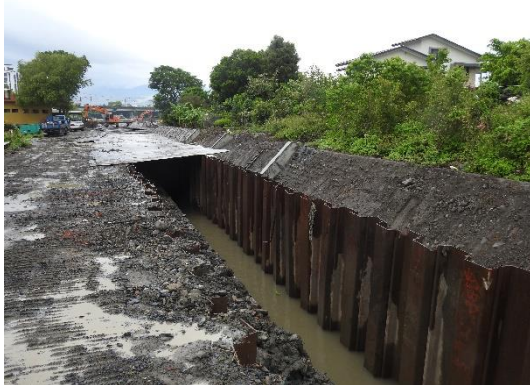
尚未完成施作的護岸
