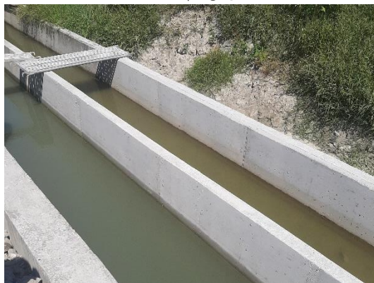
工區周遭排水側溝
