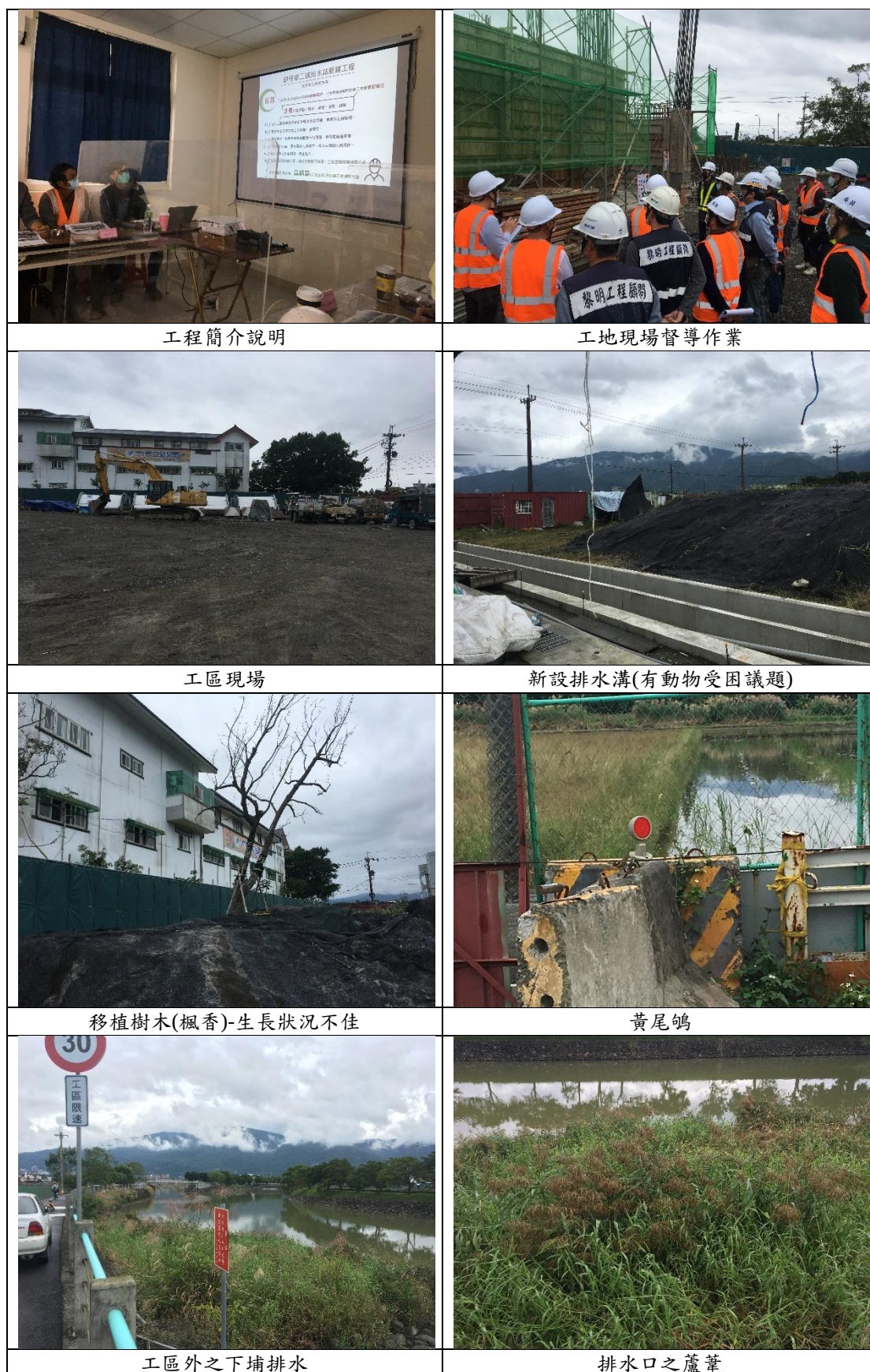
圖 7.1-1 「砂仔港二號抽水站新建工程」工程督導會議－現勘照片
