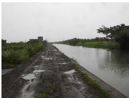
施工中現況(左岸已整地)
