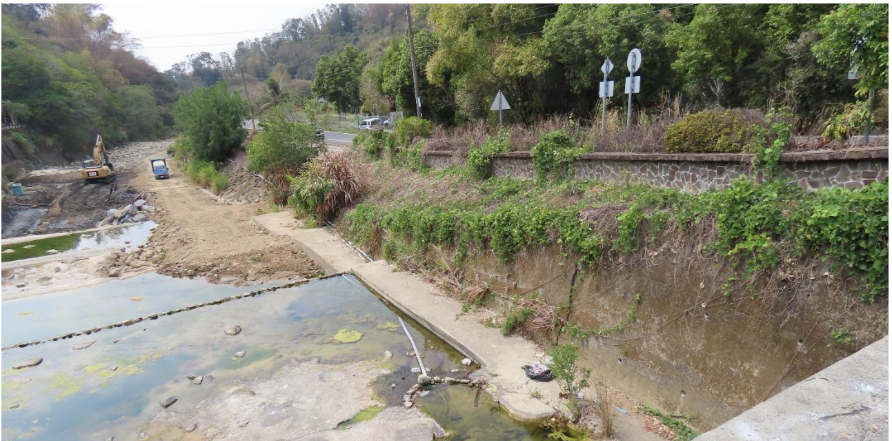
圖 3-2 112 年 3 月 14 日施工階段現勘
