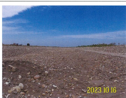
河道整理現況
