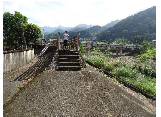
現勘南庄堤防步道與階梯
