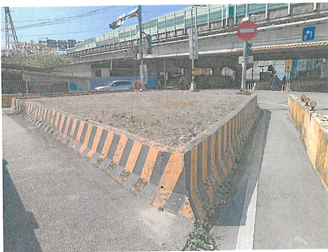
(3) 分隔島上交通號誌(包含紅綠燈、路燈、路牌、「不准駛入」的標誌)。
