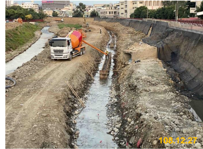
護岸基腳澆置
