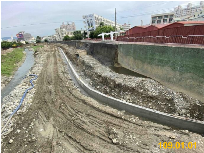
護岸基腳完成
