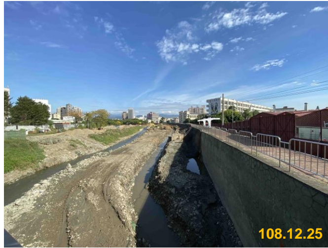
護岸基腳開挖
