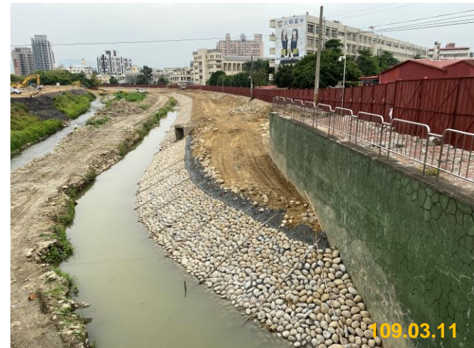
排石護坡完成
