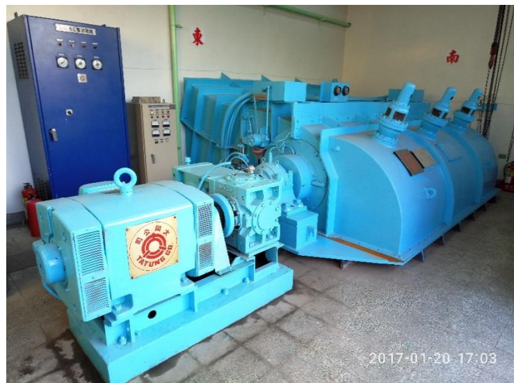
圖 10 低落差水力機組(SLH)
