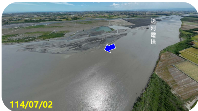
第三區 74號越堤路段 上下游
