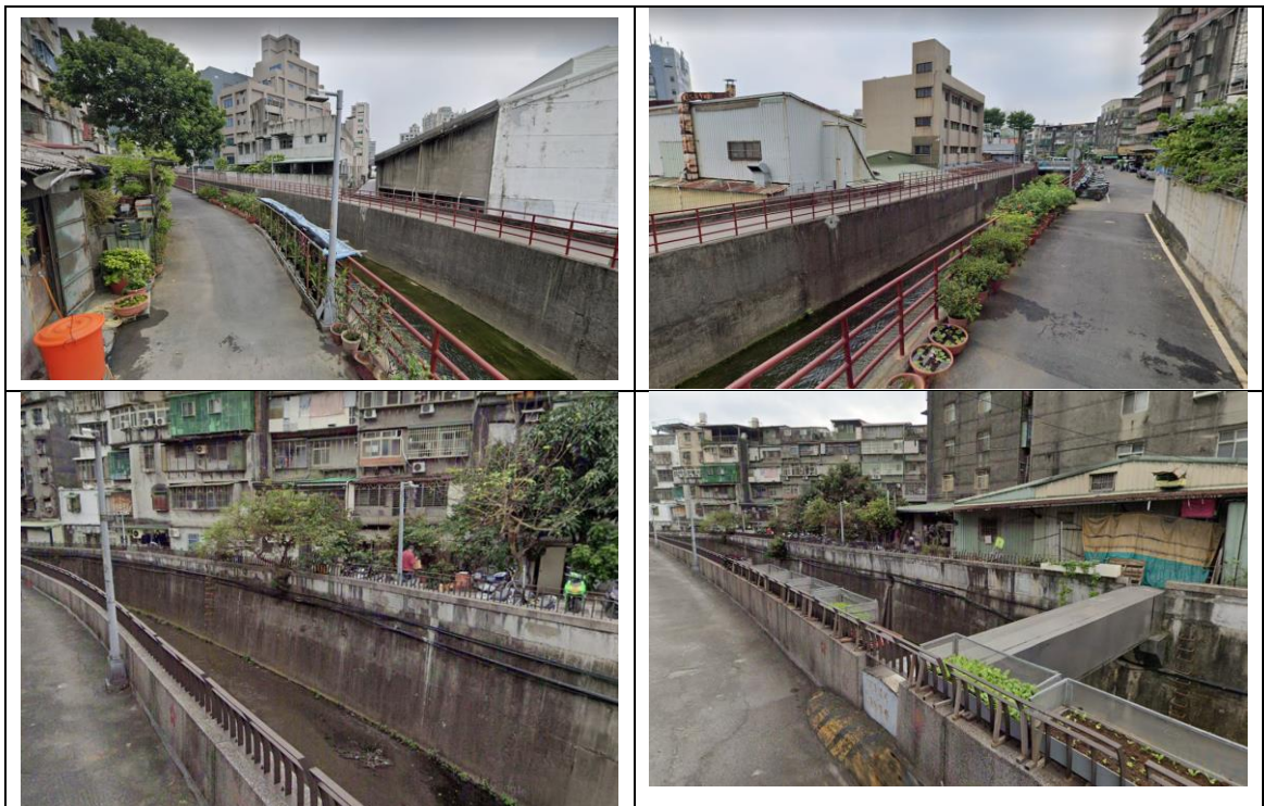
圖 6 工程計畫現地環境照
