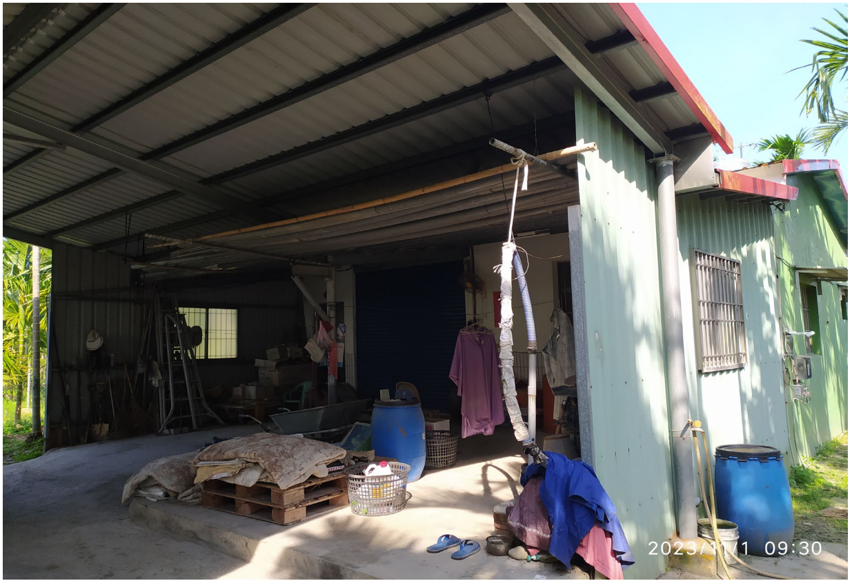
112.11.01 行為人林○珠於屏東縣高樹鄉隘寮溪大路關段搭建磚造鐵皮屋處照片
