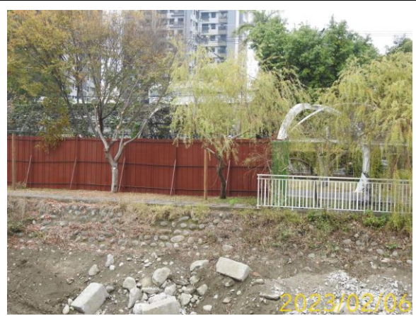
圍籬設置情況
