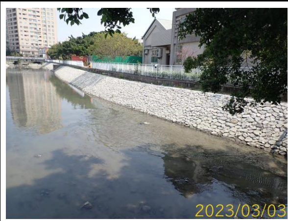
於第三區之取水口上游兩側護岸
