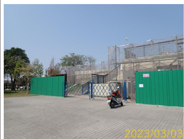
第五區水淨廠之施工圍籬
