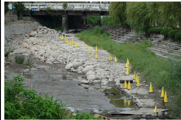
第四區施工現況
