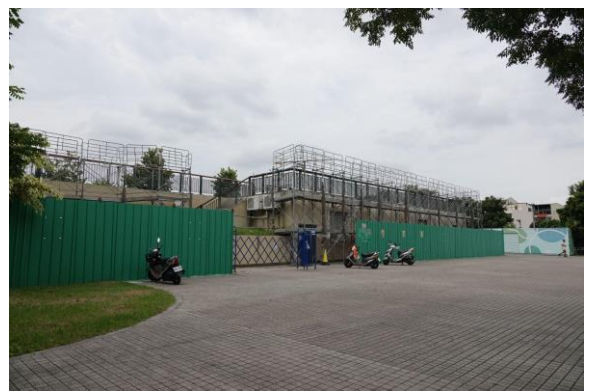
第五區施工現況
