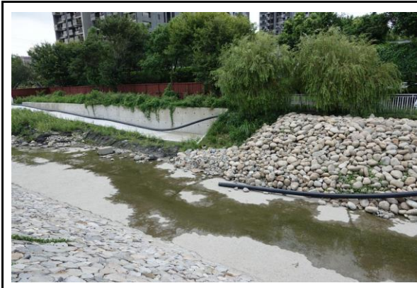
第三區取水口旁施工現況
