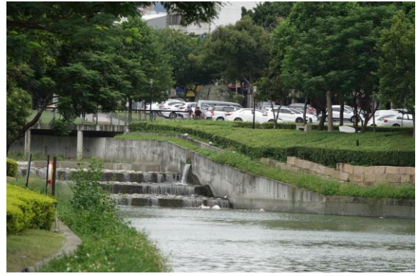
第五區施工現況
