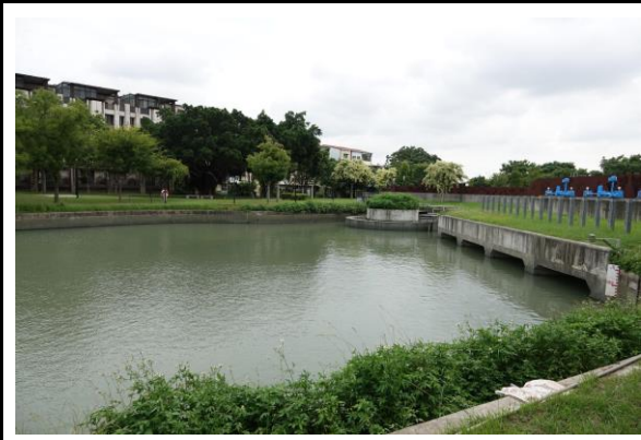
第五區施工現況
