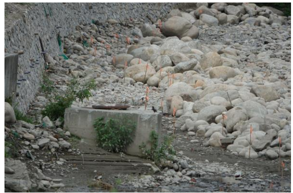
第四區施工現況
