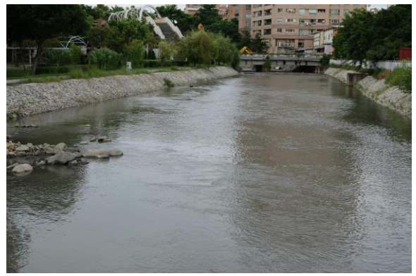
第三區取水口旁施工現況
