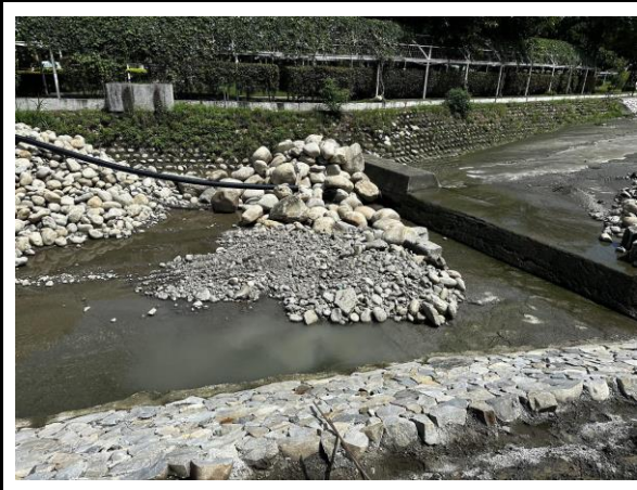
第三區取水口旁施工現況
