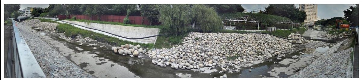
第三區施工全景
