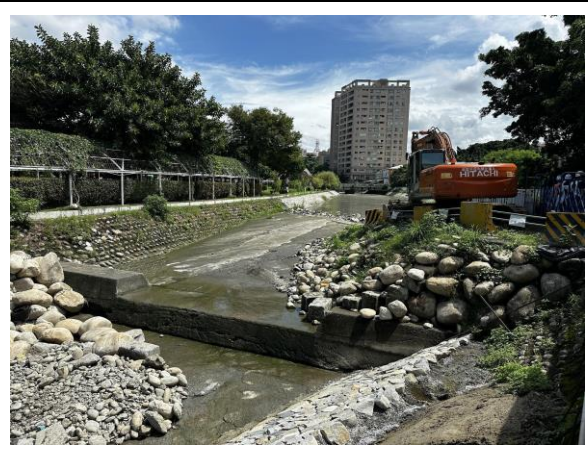
第三區取水口旁施工現況
