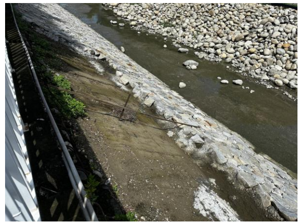
漿砌塊石施工情況
