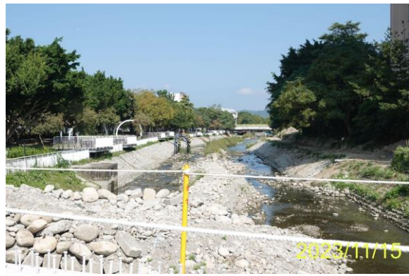
圖、採半半施工導引水流
