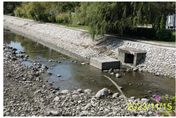
圖、施工區內目前水流情況
