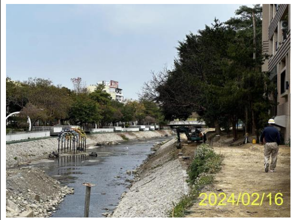
圖、二區水域施工情況
