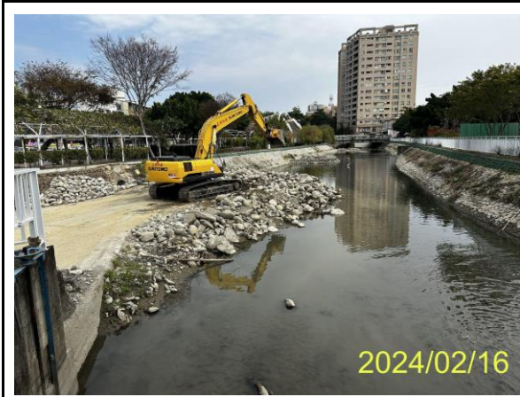
圖、三區河道施工現況
