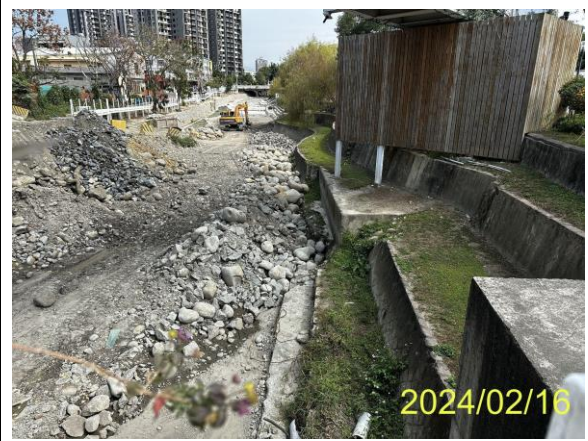
圖、施工範圍侷限於河道內
