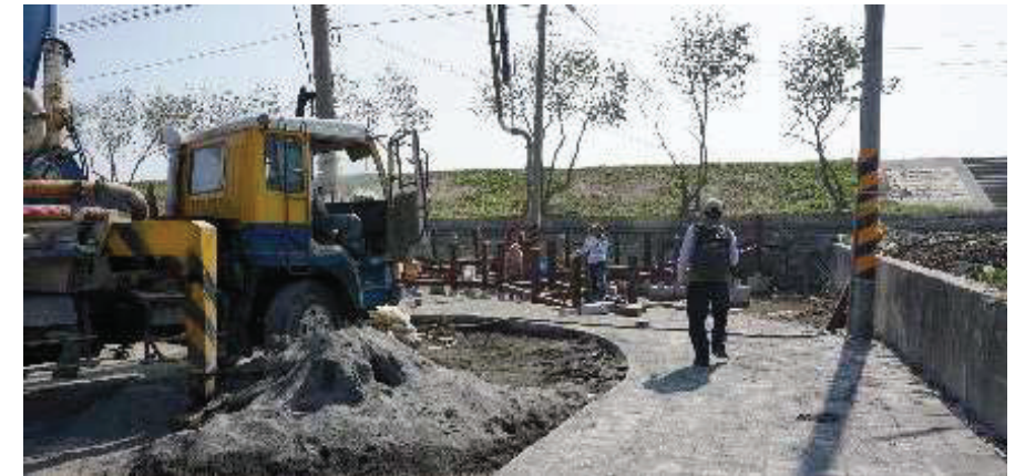
工程設施照片(既有人行設施)
