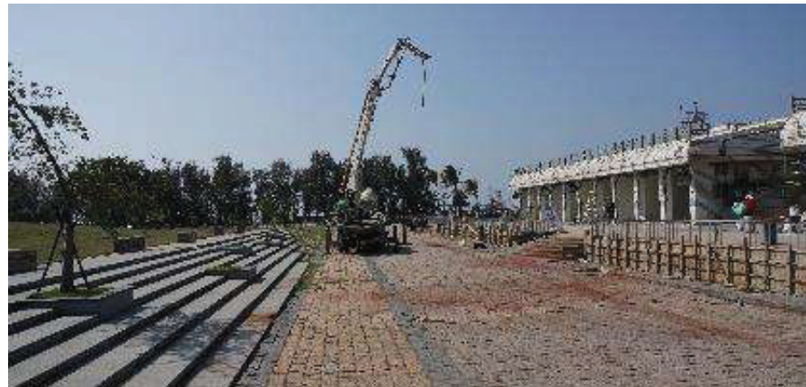
工程設施照片(既有人行設施)
