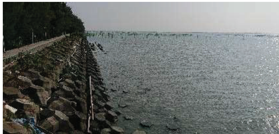
水岸及護坡照片
