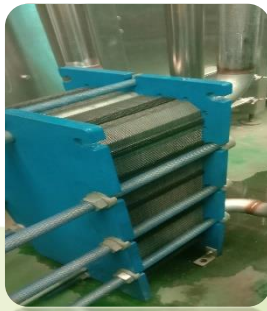
回溫機及板式交換器
