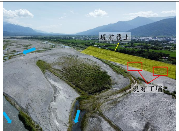
秀姑巒溪左岸已施作過提前覆土工程，且現存有兩處丁壩。
