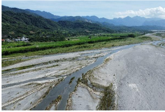
圖5 高灘地植被現況。
