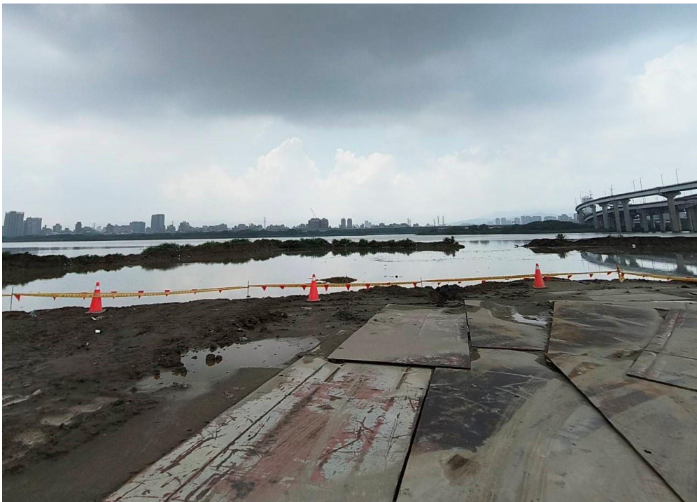
圖 3-3 二重疏洪道入口段現地狀況
