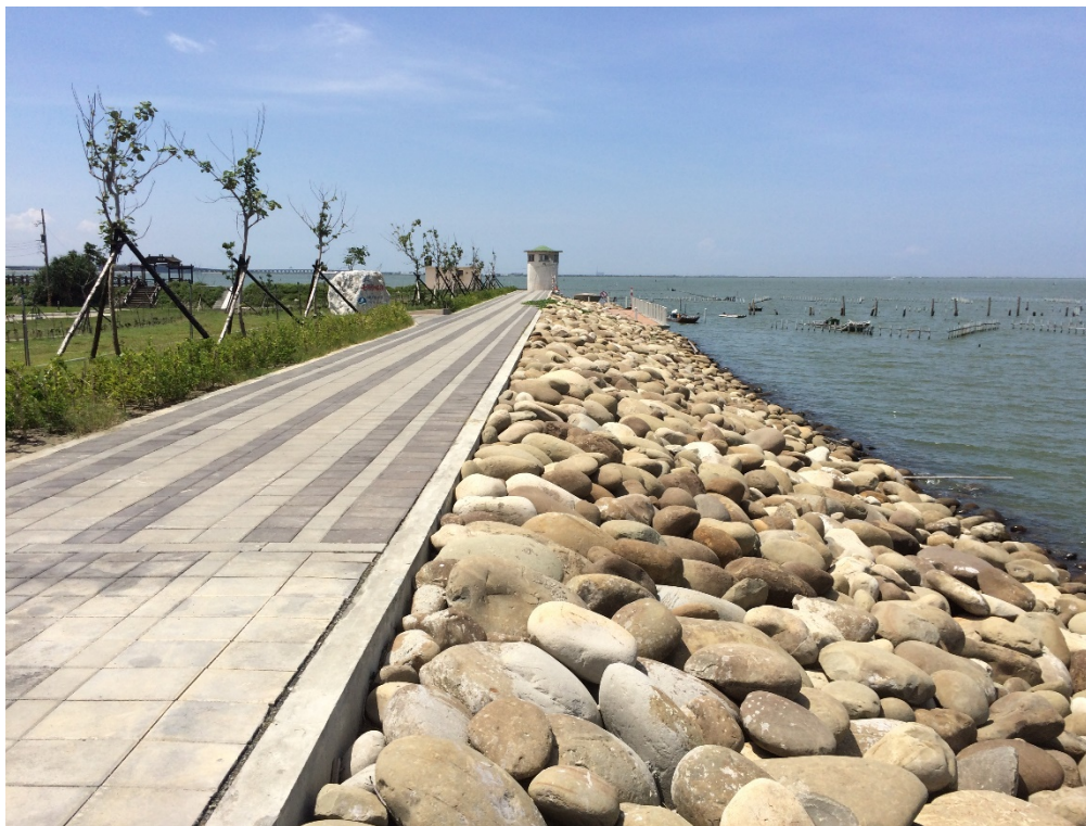
堤外：塊石護坡 + 瀉湖
