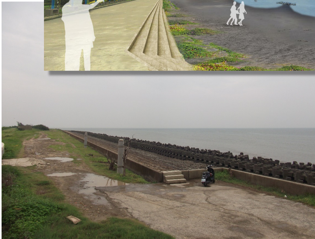
堤外：胸牆 + 砌石護坡 + 消波塊
