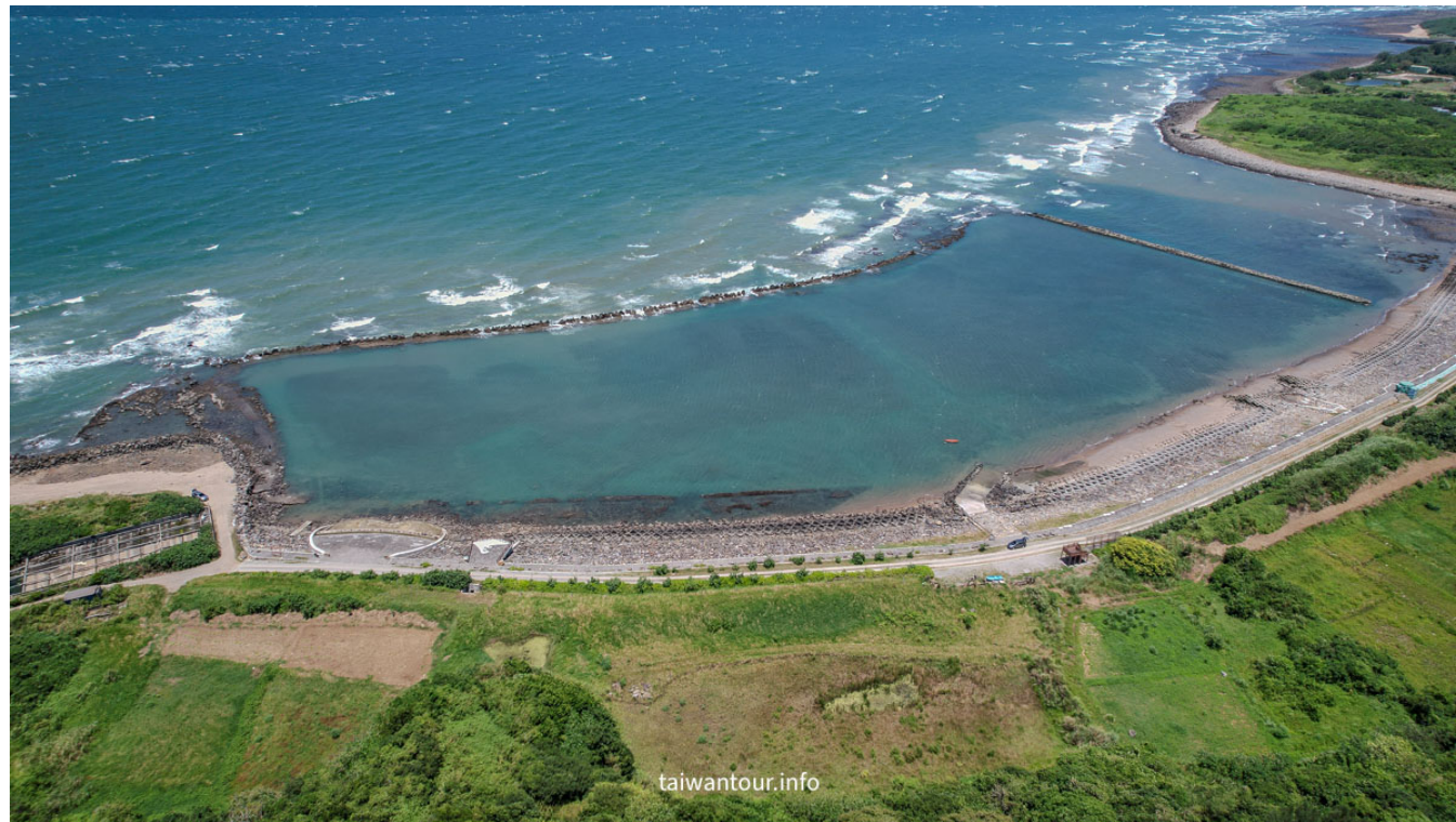
堤外：塊石護坡 + 消波塊
