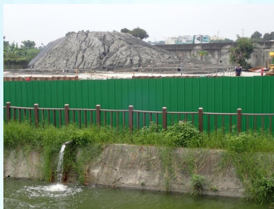
水質淨化改善工程計畫範圍現況
