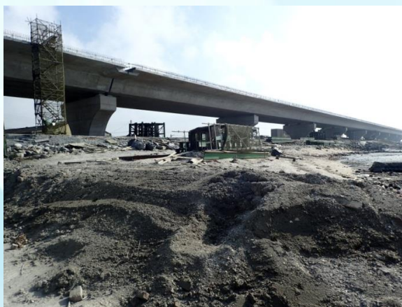
計畫範圍外之潮間帶灘地現況— 堆放有西濱工程的沙石及施工機具
