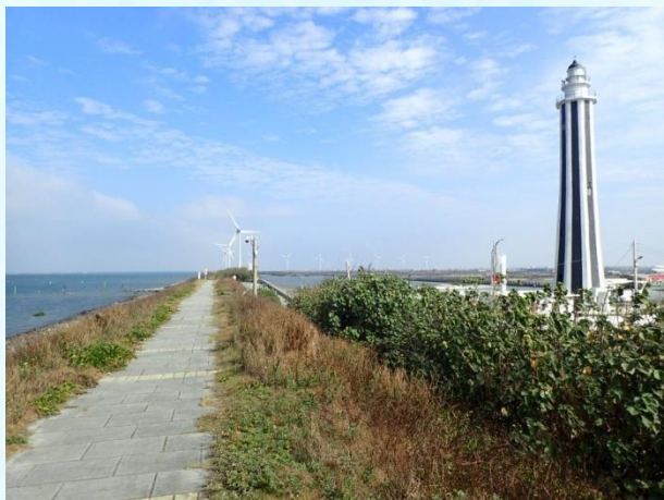
計畫範圍邊緣的堤岸環境現況
