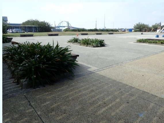
計畫範圍內的廣場設施現況
