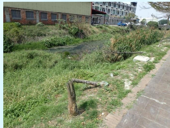
部分河道旁有景觀樹木乾枯未整理
