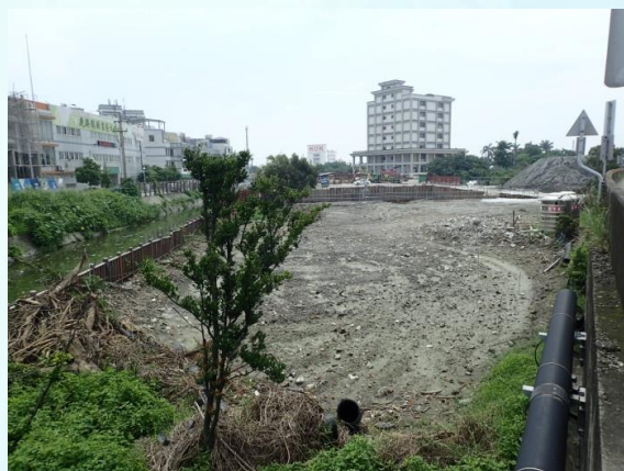
水質淨化改善工程計畫範圍現況
