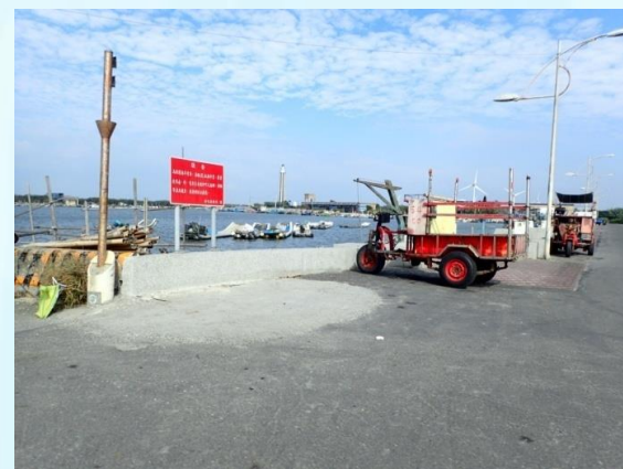
計畫範圍內之漁船停泊區現況
