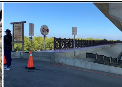
現況堤頂步道
