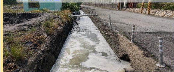
⑤ 大潭新支線支流，現況護岸老舊應整體改建
