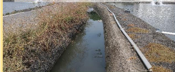
⑤ 大潭新支線支流，現況護岸老舊應整體改建
