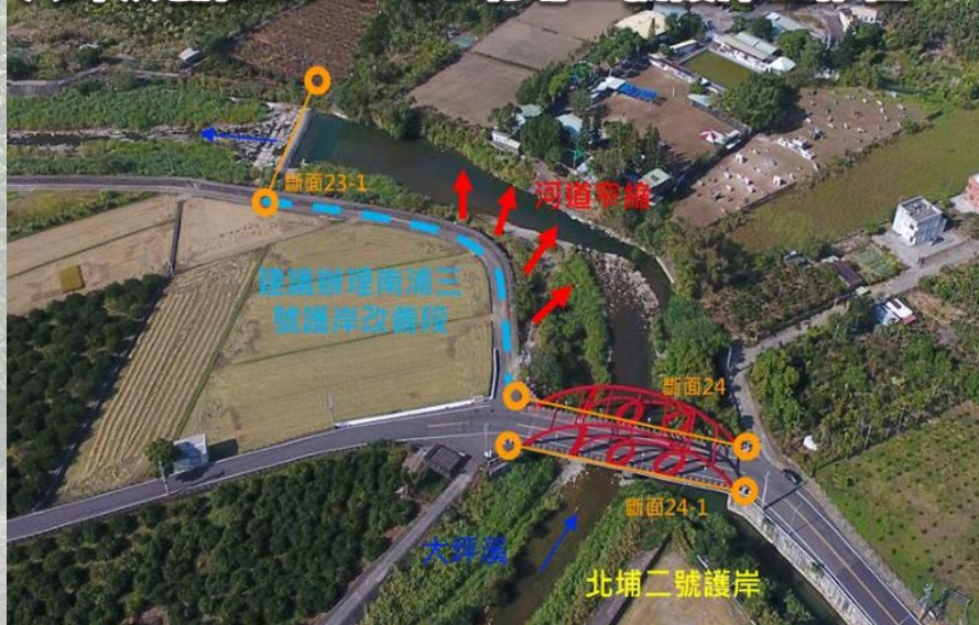
大坪溪斷面23-1~24北埔二號護岸空拍圖
