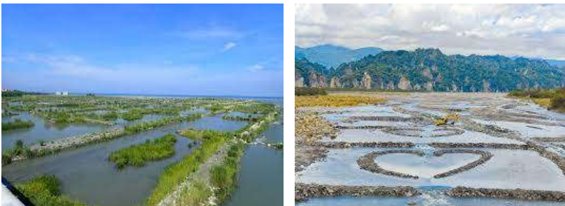
卑南溪水覆蓋工法示意圖
