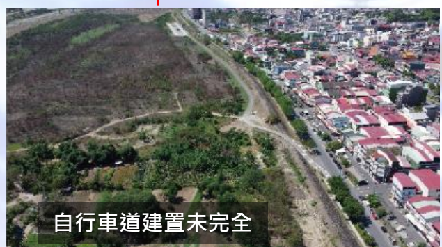
前坡灘地皆淤積嚴重，淤積可能使通洪面縮小
