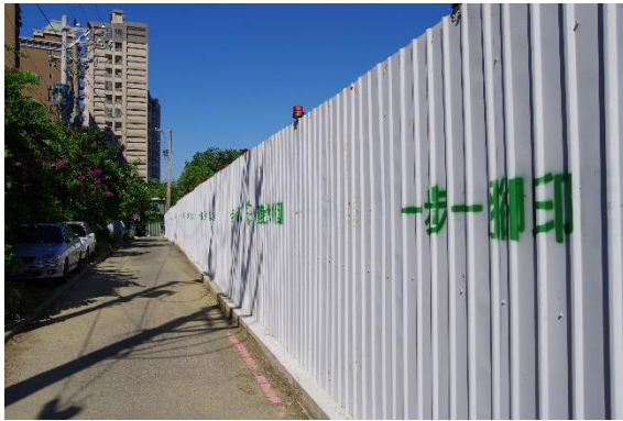
108/09/22 現場施工照片
