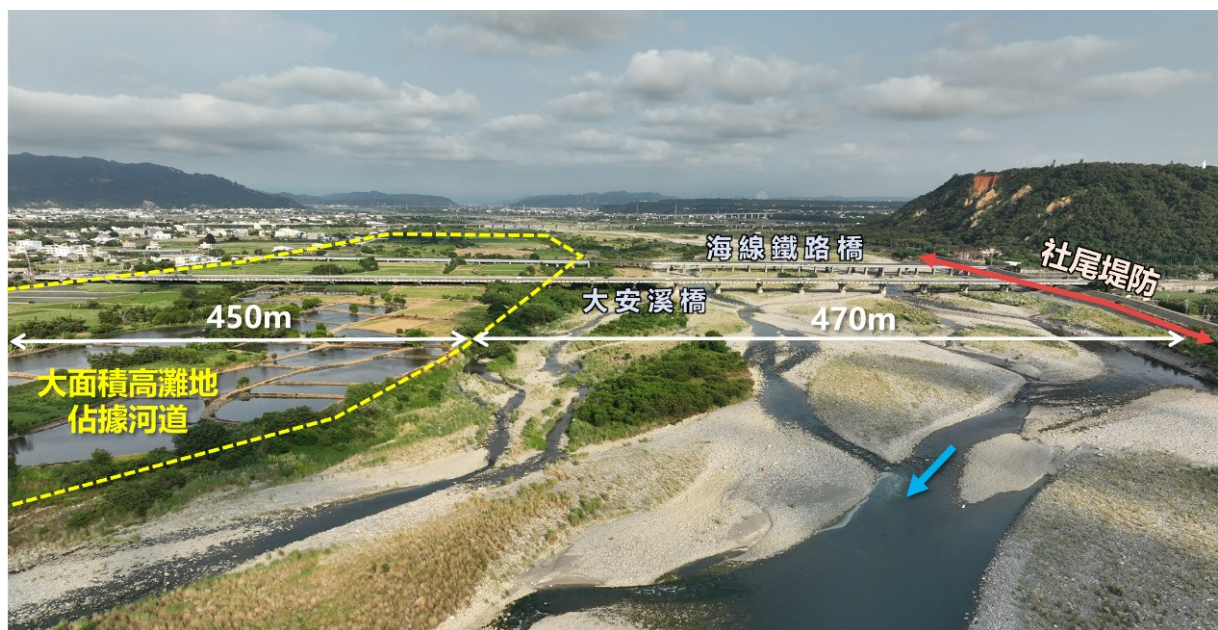
圖 3-23 社尾堤防段現況空拍圖
