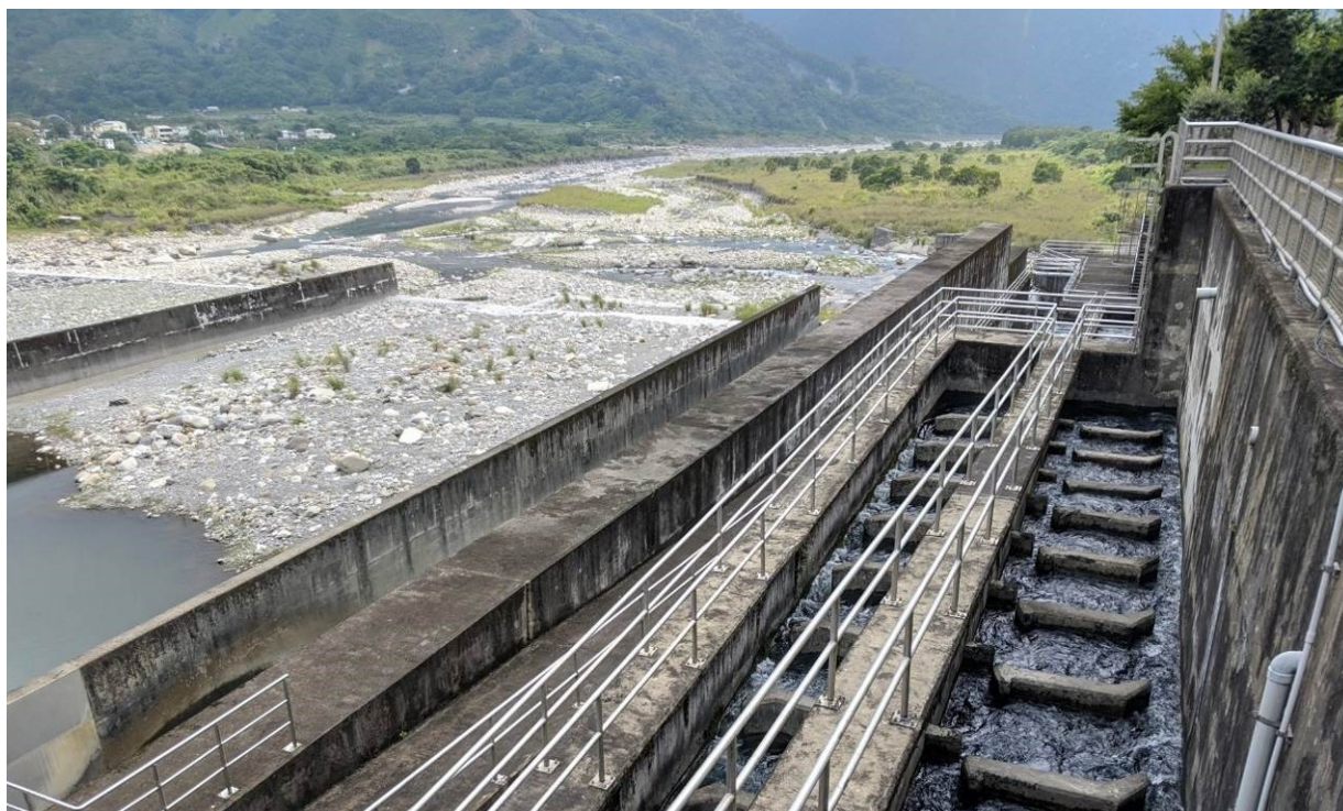
圖 3-32 士林攔河堰之水池式魚道
