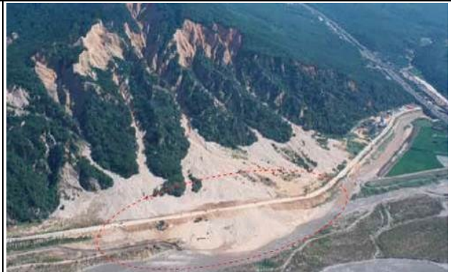
民國 93 年艾利颱風火炎山路堤遭土石掩埋
