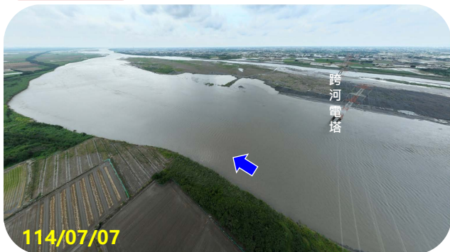
第三區 跨河電塔 下游
