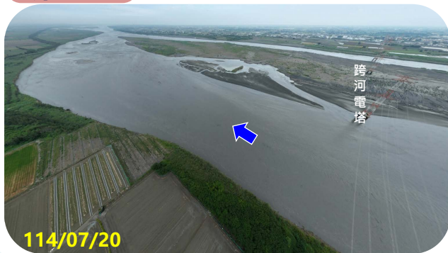
第三區 跨河電塔 下游
