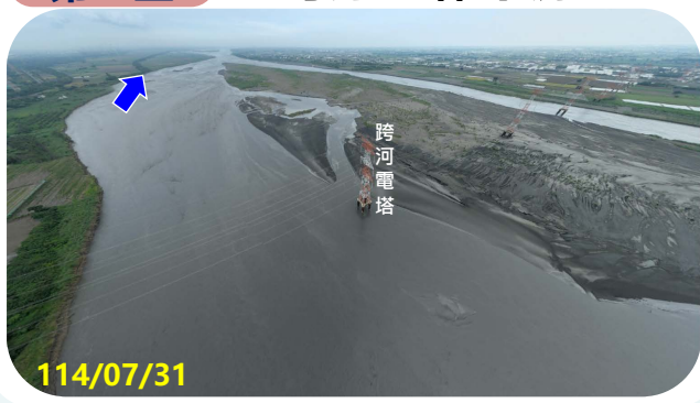
第三區 跨河電塔 下游
