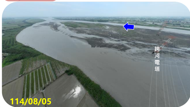
第三區 跨河電塔 下游
