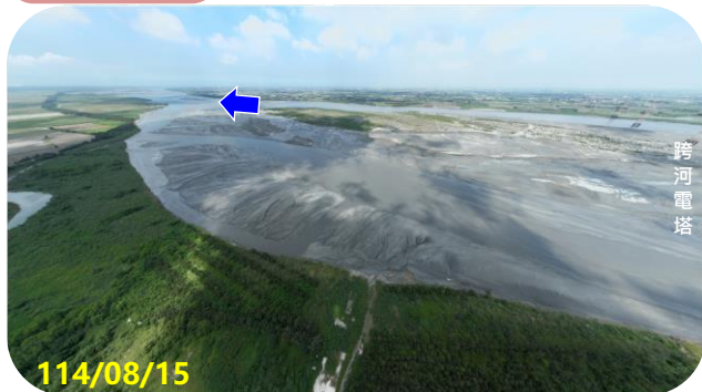
第三區 跨河電塔 下游
