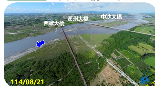
第五區 西螺大橋 上下游
