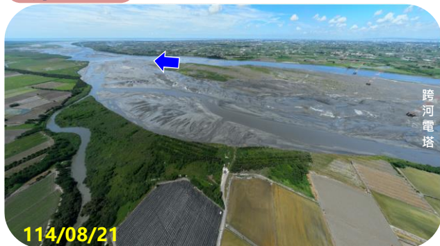
第三區 跨河電塔 下游
