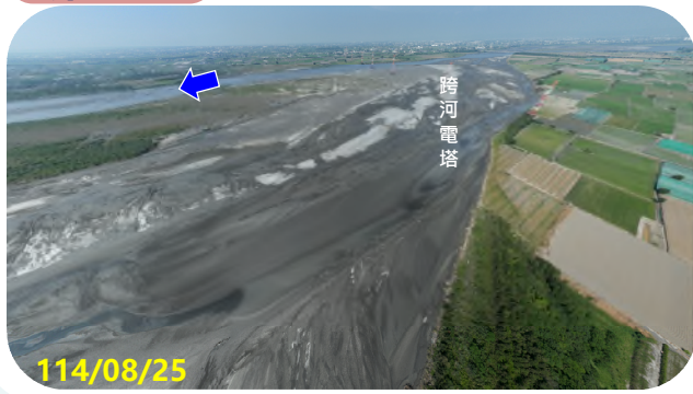
第三區 跨河電塔 下游
