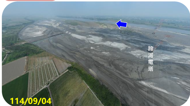
第三區 跨河電塔 下游
